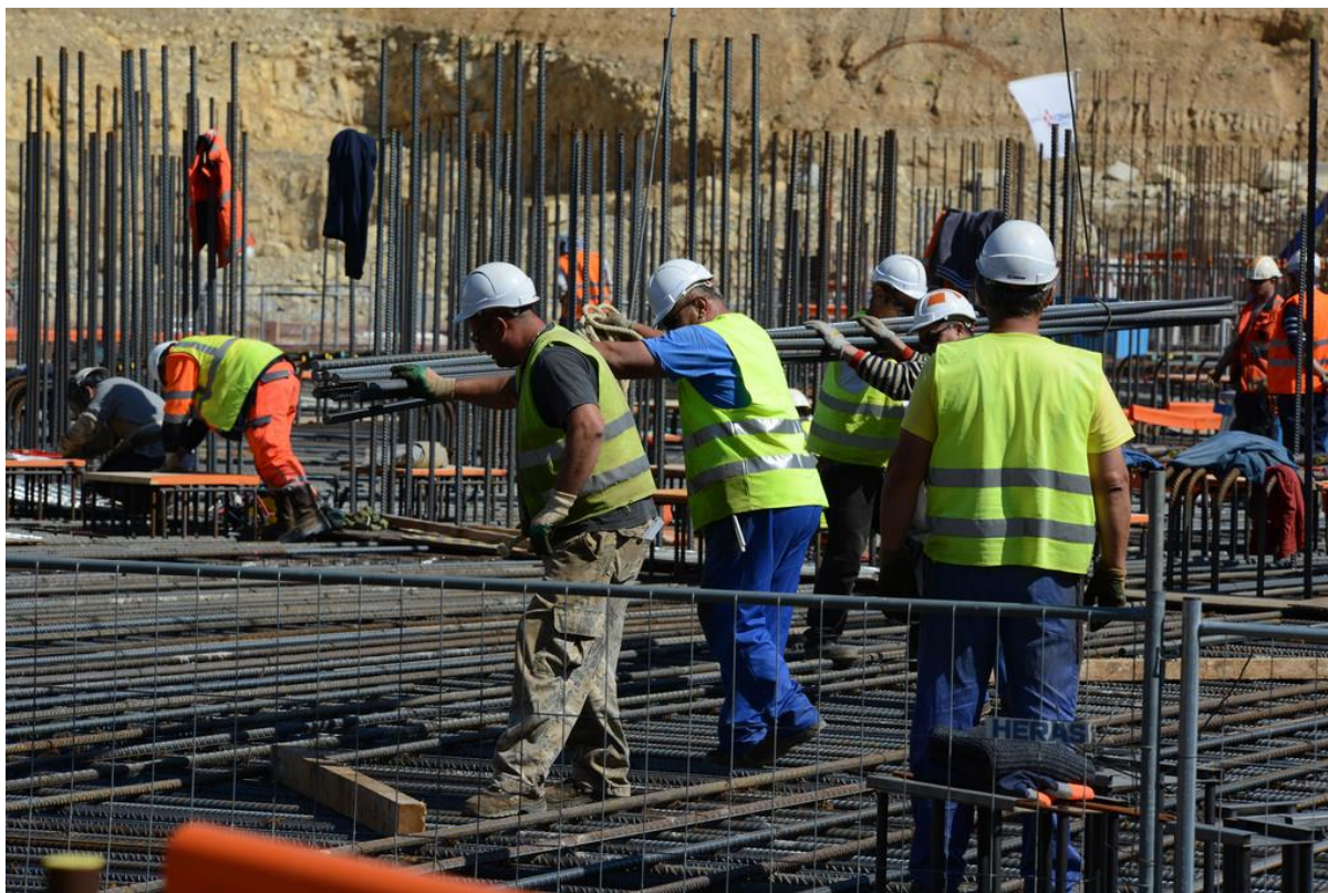
Слика 5: Лична заштитна опрема при изведба на армирачки работи
