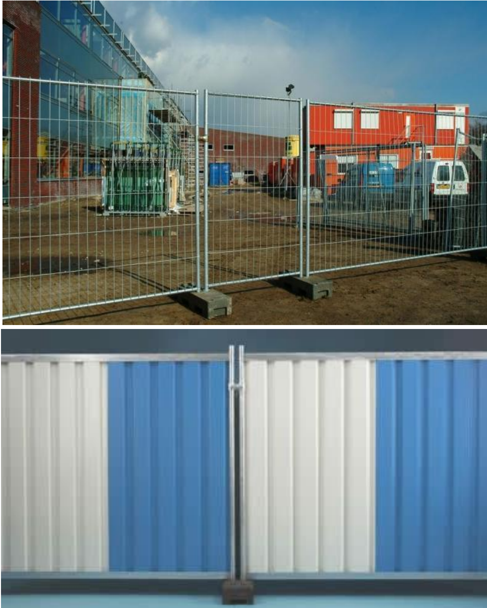
Слика бр.2: Приказ на огради за заштита на градилиште
